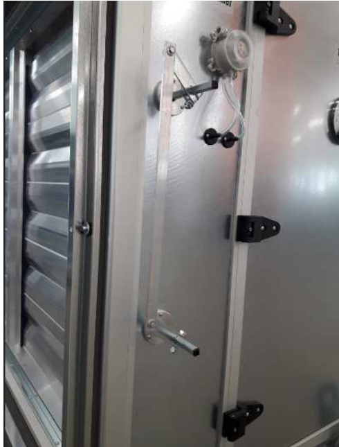
Abb. A – vor Demontage
